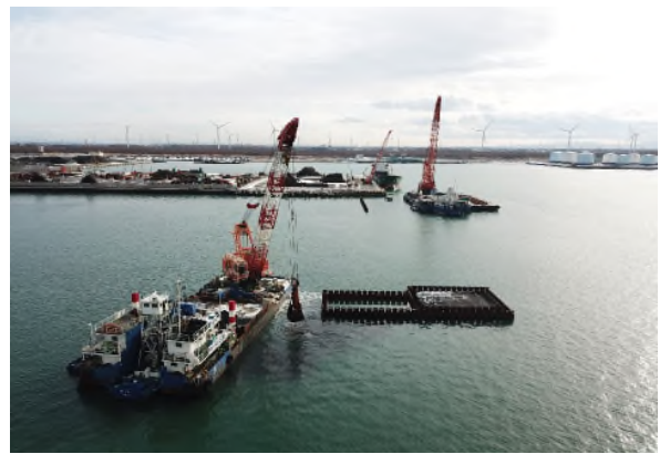
石狩湾新港水深12m岸壁 整備状況
