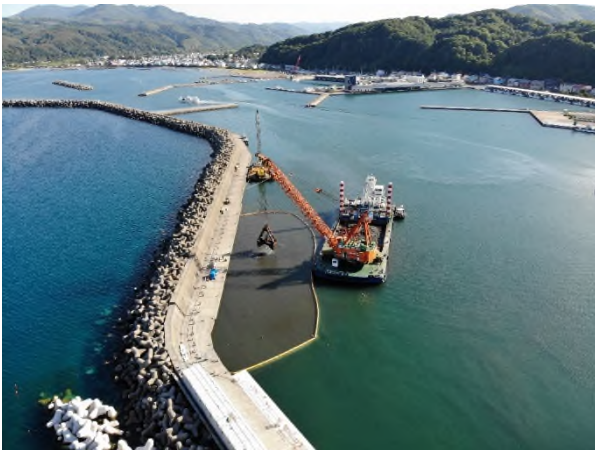
古平地区 東防波堤（改良） 整備状況
