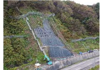
国道229号 島牧防災（法枠工）
