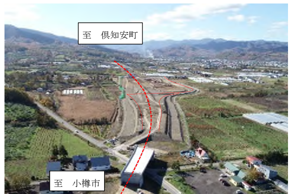
国道 5 号 倶知安余市道路（共和～余市） （（仮称）仁木 IC 付近）
