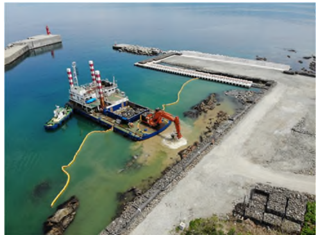
寿都地区 水深3.0m岸壁（南）等 整備状況
