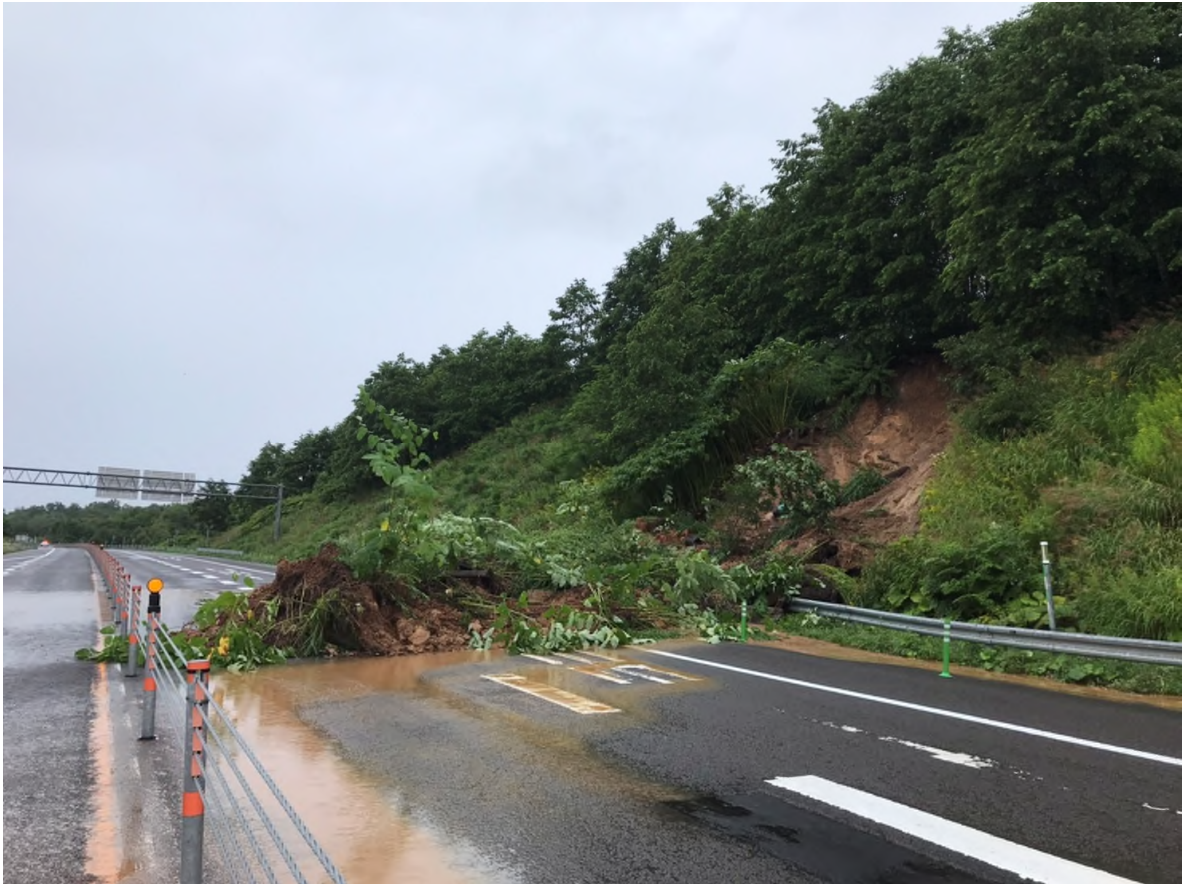
< E 5 A 黒松内新道の土砂流入状況 >
