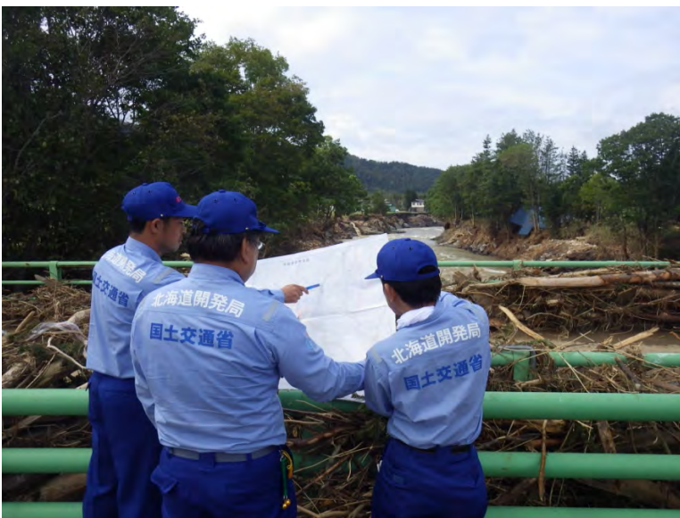
9月3日 南富良野町道橋梁流木被害(河川班)
