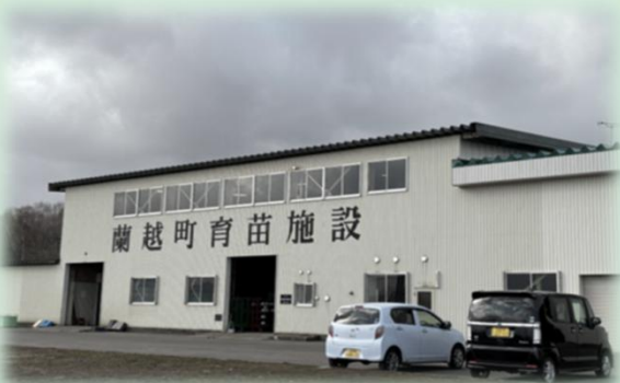
蘭越町育苗施設既設棟
