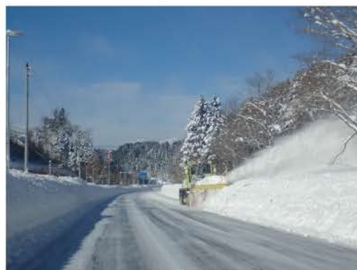
国道の除雪作業
