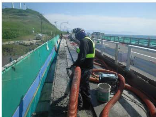
橋梁の老朽化対策(小楸子橋)
