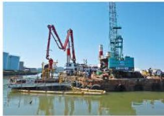
導流堤改築(留萌川)
