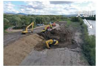
河道掘削(天塩川)
