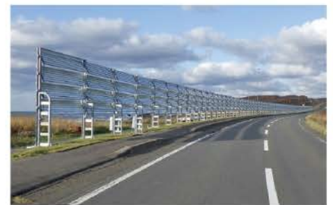
冬期の防災対策(防雪柵設置)
