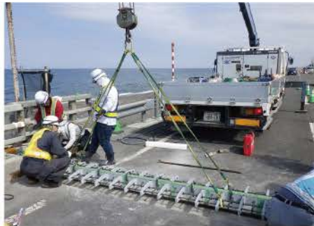
老朽化対策(橋梁補修)
