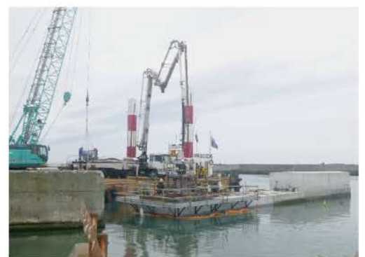
【留萌管内地区】苫前漁港東防波堤 補修状況
