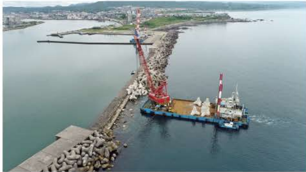
留萌港外港地区 南防波堤改良 整備状況
