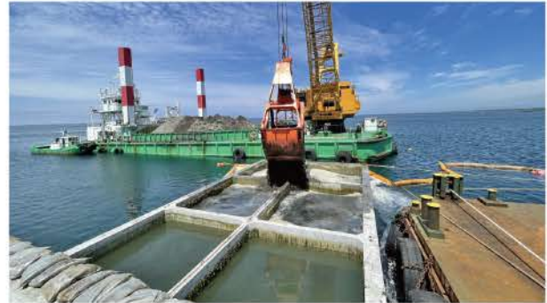
天塩港本港地区 西外防波堤 整備状況
