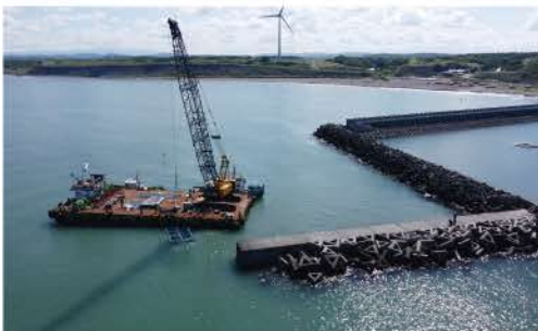
【苫前地区】東外防砂堤 整備状況
