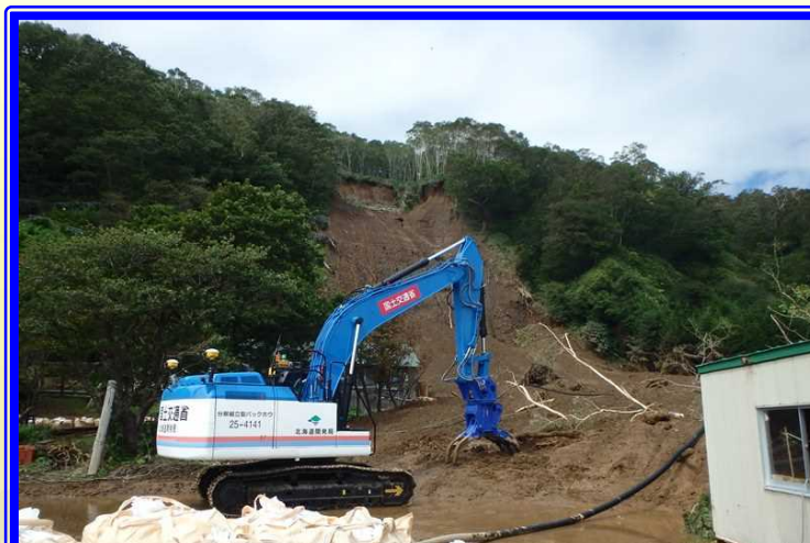
H28.8 遠隔操作による流木除去状況(羅臼町)
