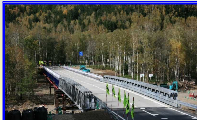
H28.8 一般国道273号上川町高原大橋架設状況
