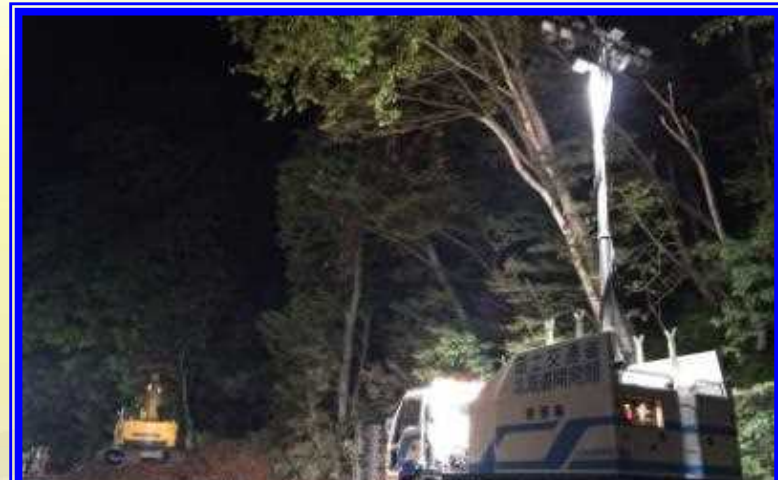
H26.9 一般国道453号 大雨に伴う土砂撤去作業による出動（千歳市）
