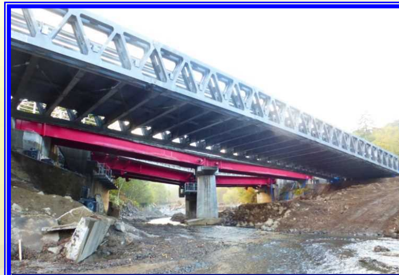
H26 一般国道453号恵庭市奥漁川橋架設状況
