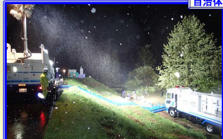
H28.8 十勝川水系途別川 大雨に伴う緊急排水作業による出動（幕別町）
