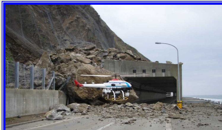
H20.5 一般国道231号 における落石による出動(増毛町)
