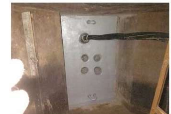
補修後（壁面補修）
