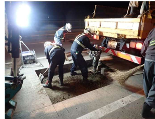
補修状況：国道12号（札幌市）
