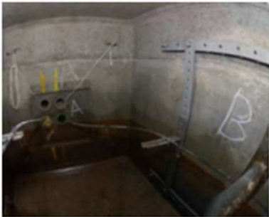
マンホール内写真
