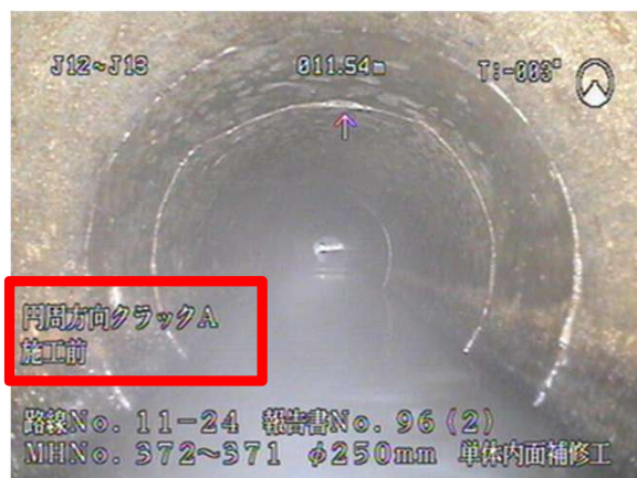
TVカメラによる管内の詳細調査
