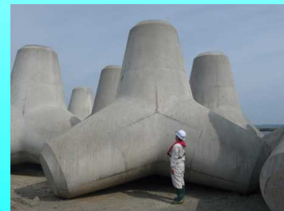
南防波堤に使用する 国内最大級の80t型消波ブロック
