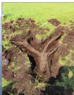
埋木による作業効率の低下
