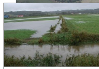
排水路からの溢水による湛水被害
