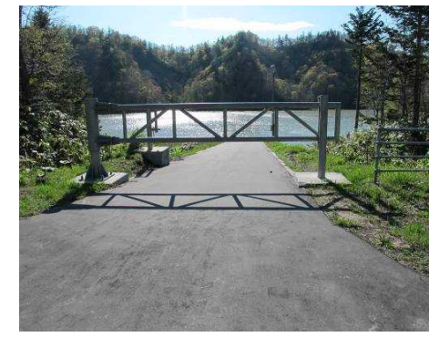
ゲート2(進入道路2)
