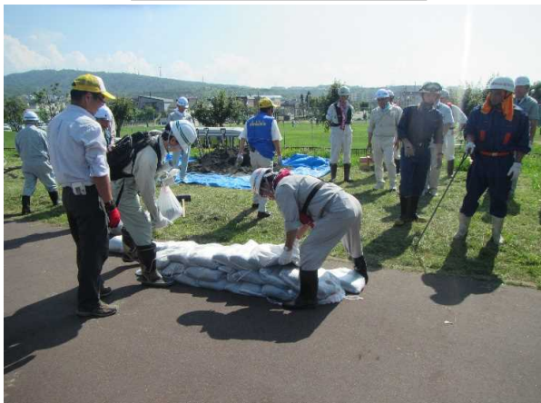
積み土のう工の実施状況
