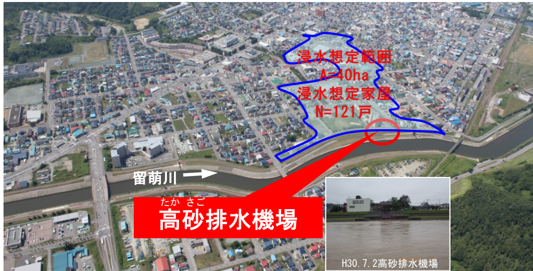
高砂排水機場が無かった場合の浸水想定範囲
