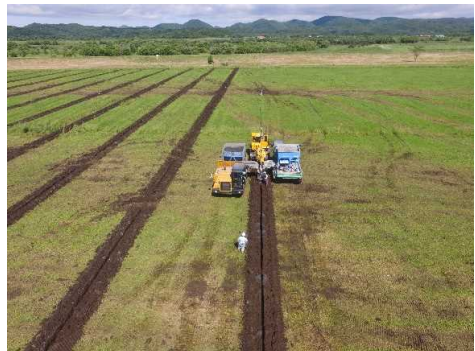
産土地区の工事施工状況
