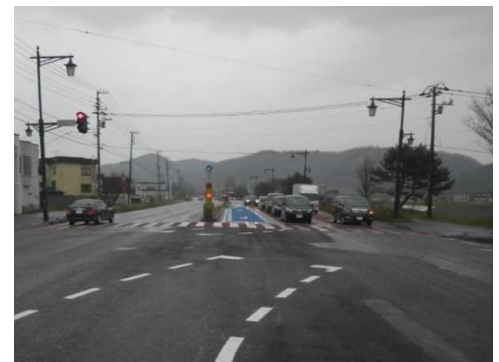
交差点改良(すべり止めカラー舗装)
