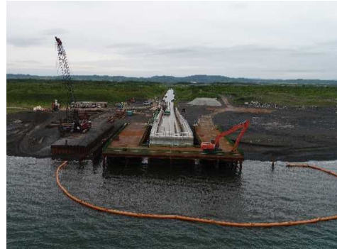
更岸地区の工事施工状況
