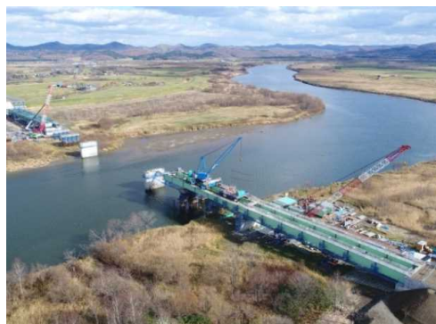
整備中の天塩防災（天塩大橋）
