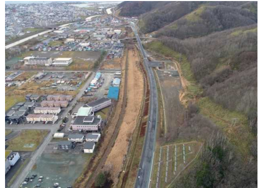
整備中の幌糠留萌道路
