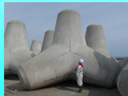
南防波堤に使用する 国内最大級の80t型消波ブロック
