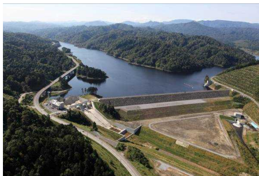
写真① ダム全景
