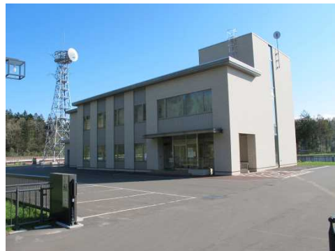
写真② ダム管理支所(管理棟)
