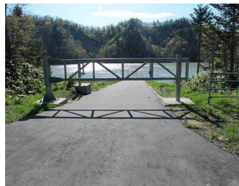
写真⑦ ゲート2(進入道路2)
