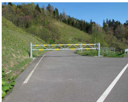
写真⑤ ゲート1(進入道路1)
