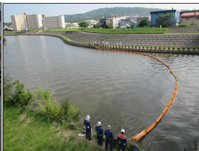
オイルフェンス設置訓練（大通り橋）
