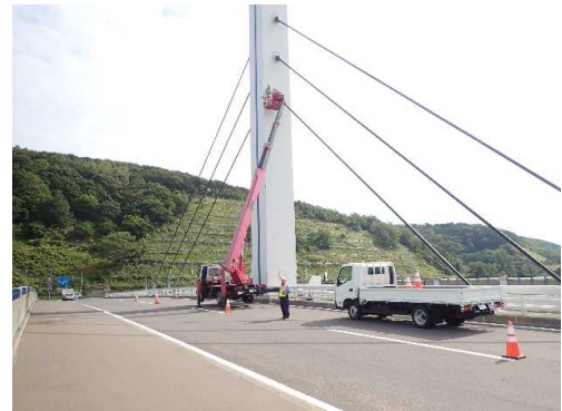
橋梁点検（ルルモッペ大橋）
