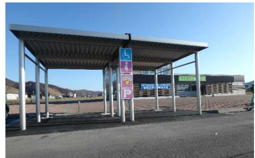
道の駅「るもい」（令和2年度オープン予定） 子育て応援施設（妊婦用屋根付き駐車スペース） 整備状況
