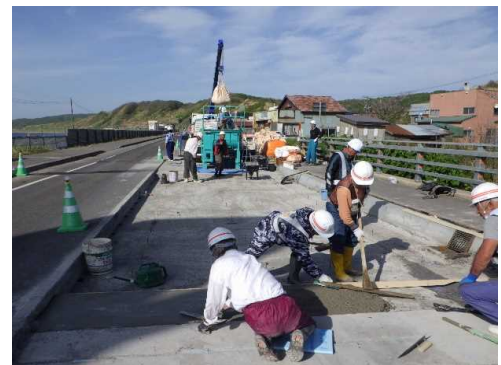
橋梁修繕（臼谷橋）
