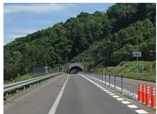
ワイヤロープの設置状況
