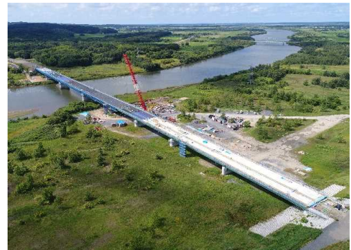
整備中の天塩防災（天塩大橋）
