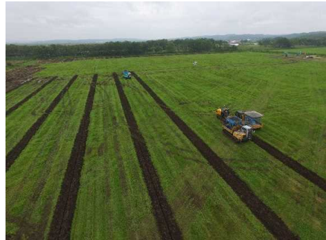
産土地区の工事施工状況
