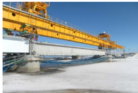
北海道232号耐震補強(築別橋)
