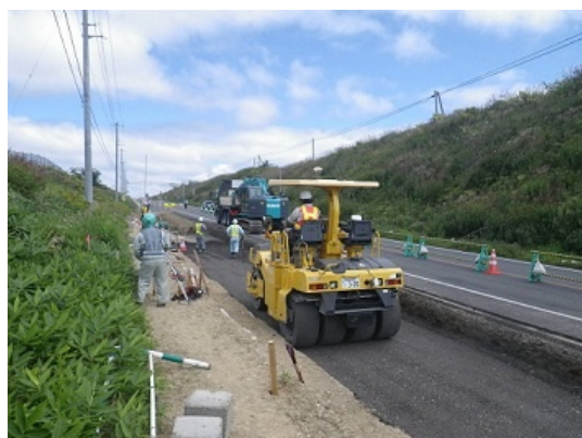
金駒内事故対策(登坂車線・中央帯)
