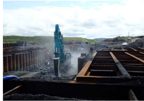
更岸地区の工事施工状況
