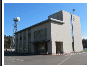
留萌ダム管理支所
