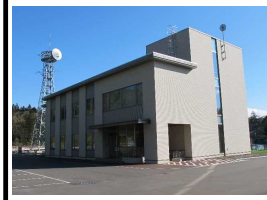
留萌ダム管理支所
