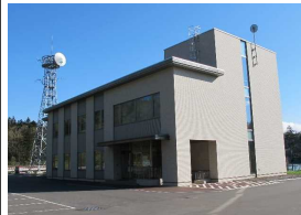
留萌ダム管理支所
