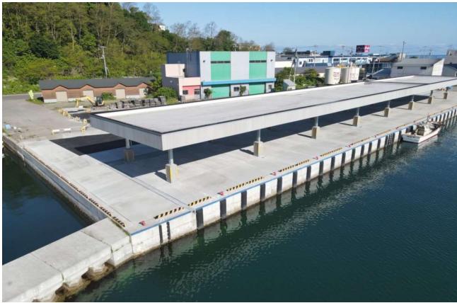
屋根付き岸壁(全景)
