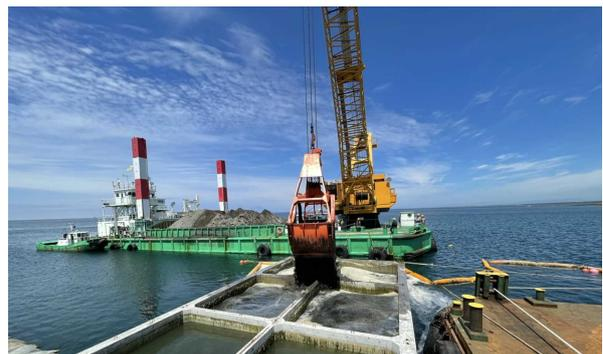
ケーソン中詰砂投入の施工状況
