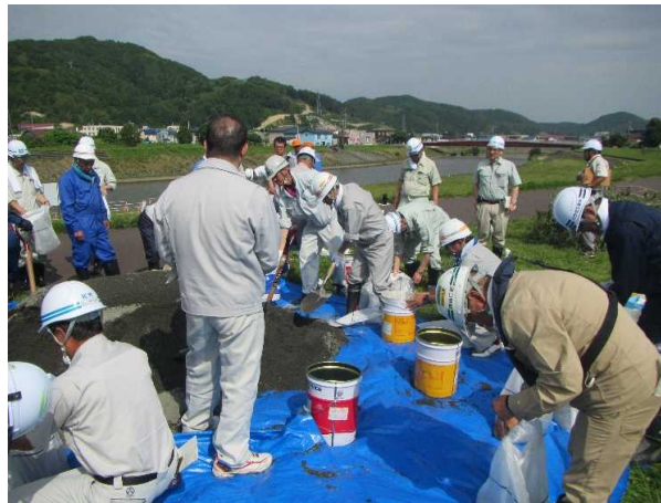
土のうの作り方を学び、土のう製作
