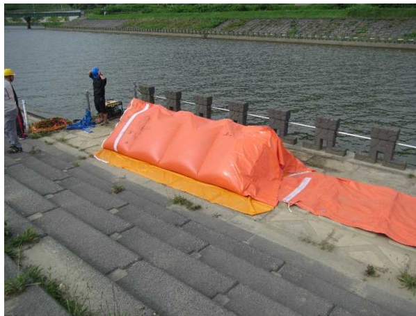
水マット工法の実施状況
