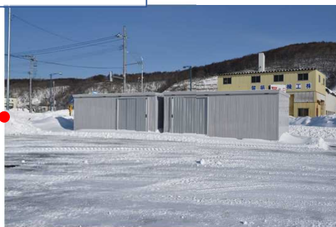
防災資機材倉庫
