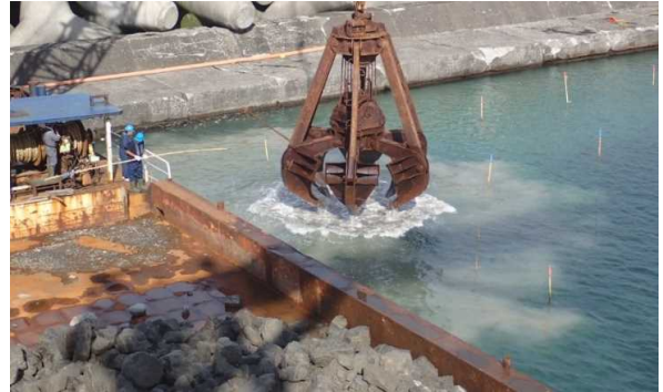
南防波堤の捨石投入状況
