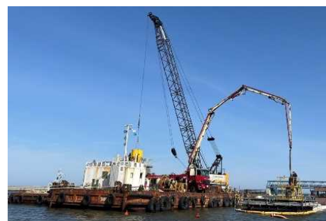
導流堤改築(留萌川)
