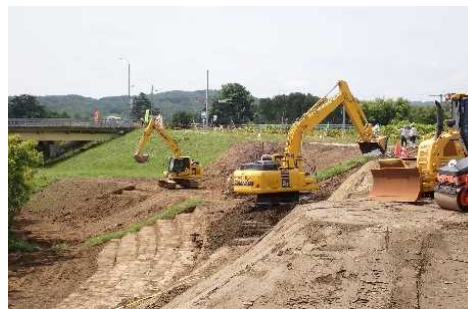
堤防整備(天塩川水系雄信内川)
