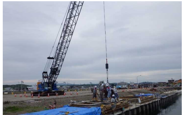
-4m物揚場の上部工打設状況
