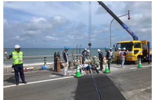
橋梁修繕（押白志橋）
