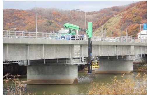
橋梁点検（高砂橋）
