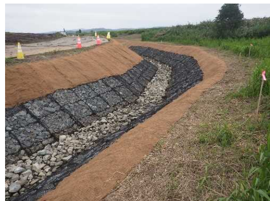
産土地区の排水路及び暗渠排水施工状況
