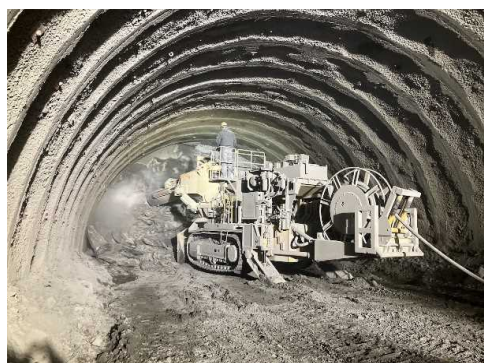
道路の防災対策（霧立防災）
