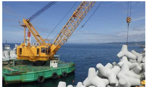
北防波護岸の消波ブロック据付状況
