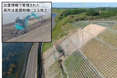
道路斜面の防災対策（ICT施工の導入） （苫前町力屋）
