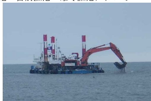
苫前漁港 航路浚渫状況
