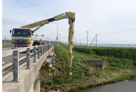
橋梁点検（国道232号旭橋）
