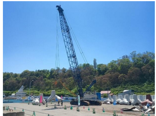
北防波護岸の消波ブロック製作状況
