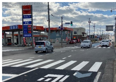
交通安全対策（交差点改良）
