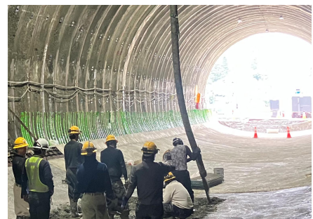
道路の防災対策（霧立防災）
