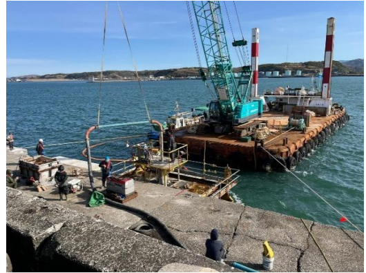
南防波堤の本体エコンクリート打設状況
