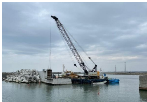
南防波堤上部コンクリート打設状況
