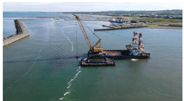
水深6m航路の浚渫状況
