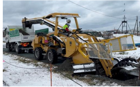
トレンチャー掘削機の導入
