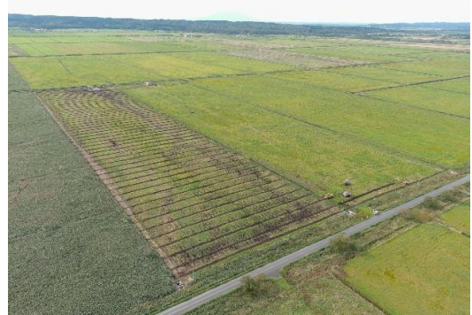
産土地区の暗渠排水施工状況
