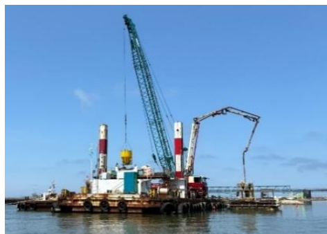
導流堤改築(留萌川)
