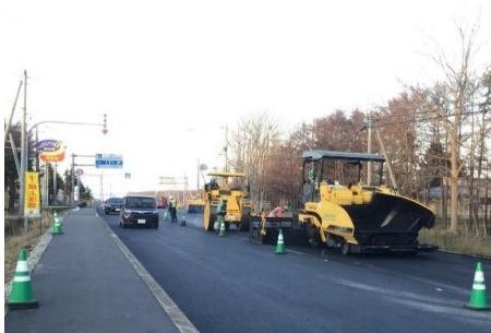
舗装修繕（国道232号初山別村）
