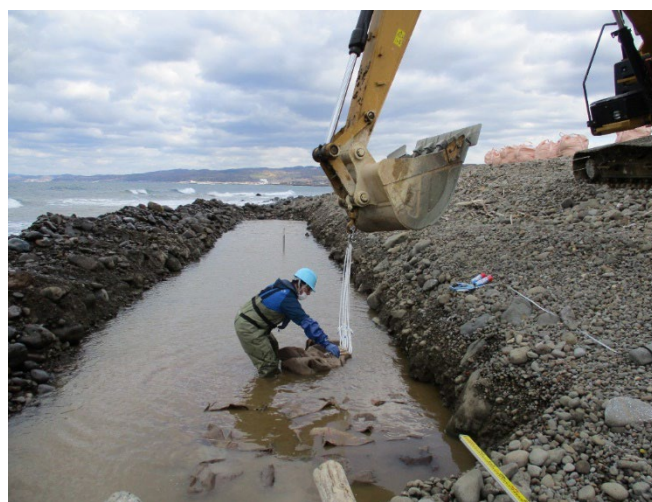
▲鉄分供給ユニット(ビバリーバック)の埋設
