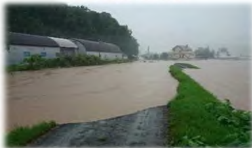
河川決壊・氾濫 (常呂川水系 常呂川)
