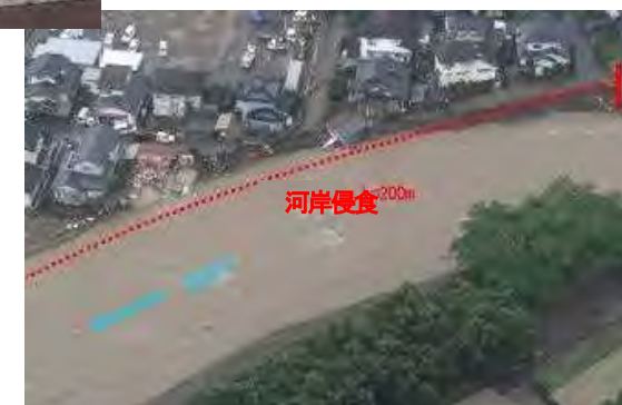
河岸侵食に伴う 家屋倒壊等
