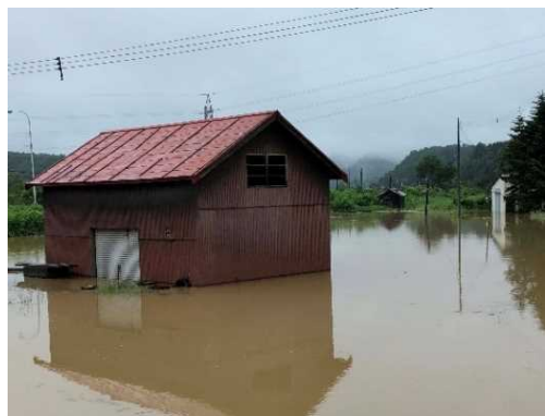
①SP400付近の浸水状況
