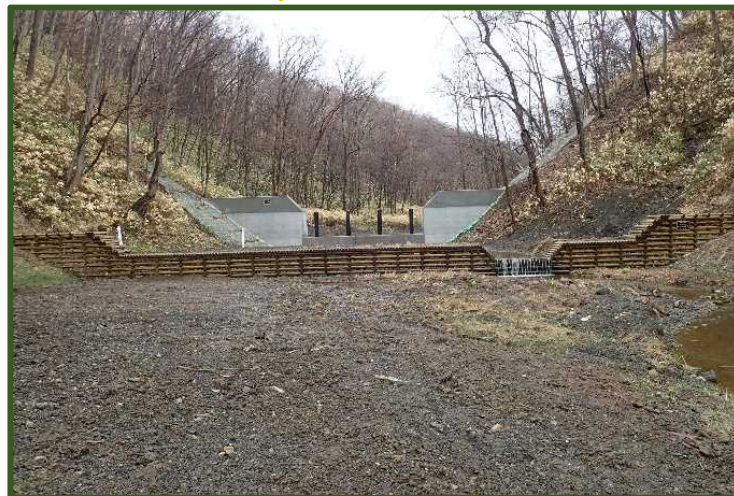
【治山ダム(流木捕捉式・床固工)】
