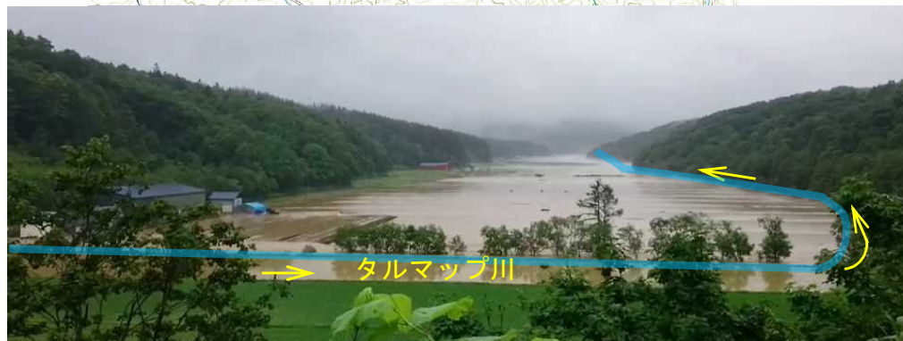
②SP3000付近(樽真布橋下流)の浸水状況
