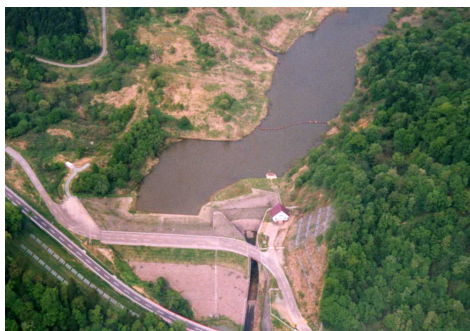
中幌ダム(留萌市)
