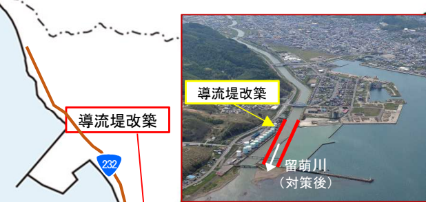
下流市街部の被害を軽減する導流堤改築 (留萌開発建設部)
