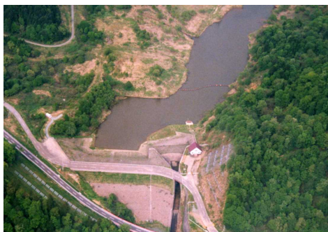
中幌ダム(留萌市)
