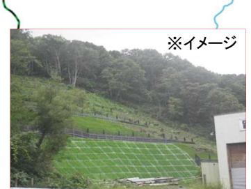
市街地等を土石流から守る砂防関係施設の設置 (留萌振興局)
