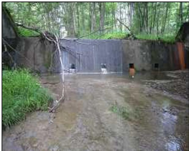
コンクリート側壁・水叩を設置することで安定した溪床勾配へ導くとともに、下流の洗掘防止に努めた。
