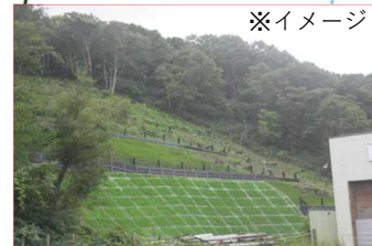
市街地等を土石流から守る砂防関係施設の設置 (留萌振興局)
