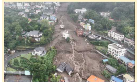
土砂災害の状況 (静岡県熱海市)
