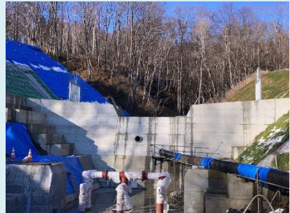
砂防堰堤の施工状況
