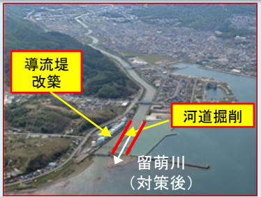
導流堤改築の実施状況
