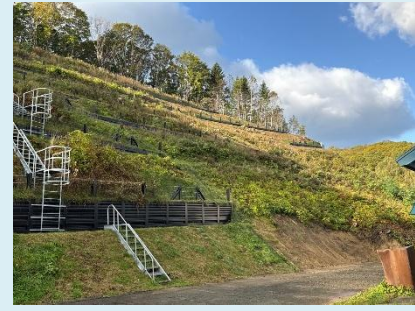
急傾斜地崩壊対策施設
