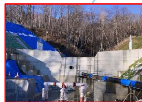
市街地等を土石流から守る砂防関係施設の設置 (留萌振興局)
