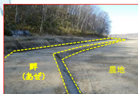
水田の貯留機能確保のための農地整備 (留萌振興局、留萌市)
