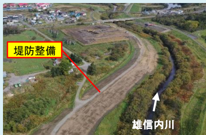
堤防整備の実施状況
