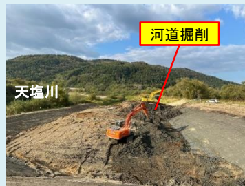
河道掘削の実施状況
