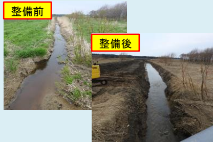
川口八号川の河道掘削
