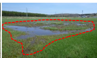
不陸による停滞水
