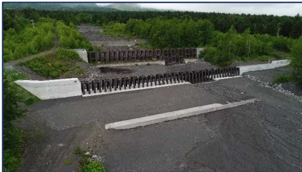
【治山ダム（土石流対策（スリット式）床固工）】 ・設置時の状況
