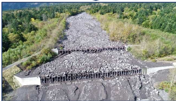
【流出抑制の効果状況】 令和2年8月7日の豪雨により上流域から土石流が発生し、上記、治山ダムの効果が発揮され土砂（中には流木も確認。）を捕捉し、下流域への流出を軽減している。
