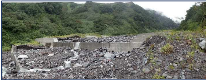
・上流域の土砂堆積状況
