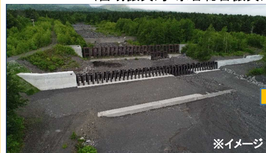
例：治山施設の整備
