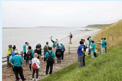
天塩川河川公園の管理用通路（天塩かわまちづくり）
