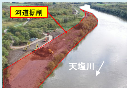
河道掘削の実施状況
