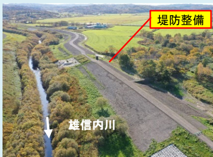
堤防整備の実施状況
