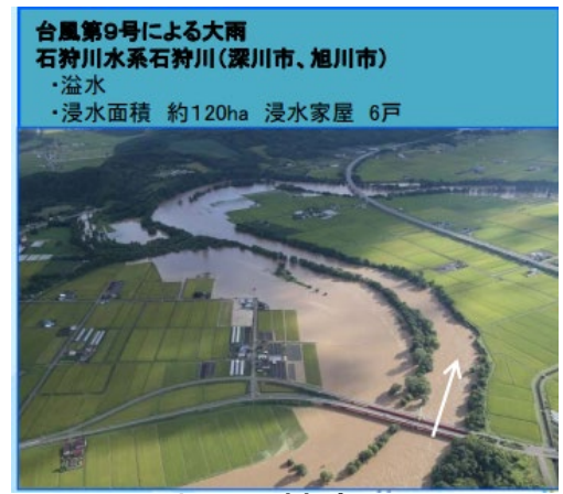
石狩川の被害状況
