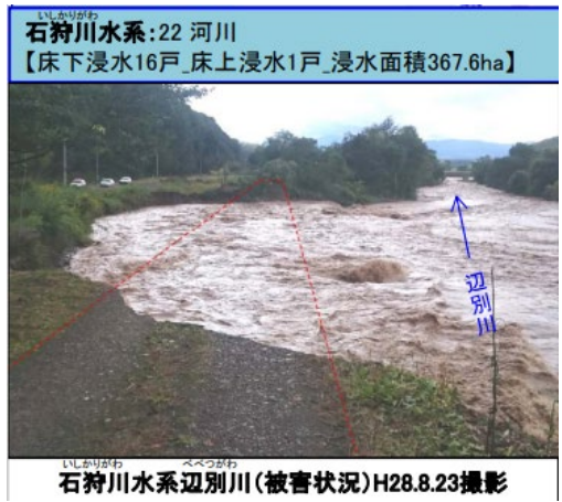
辺別川の被害状況
