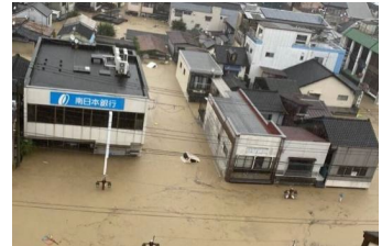
⑩ 球磨川における浸水被害状況 (熊本県人吉市)
