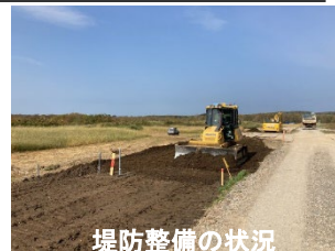
堤防整備の状況
