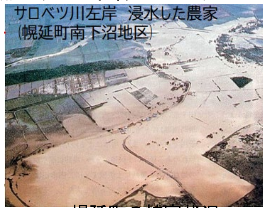
幌延町の被害状況
