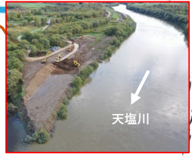
天塩川下流域を守る河道掘削 (留萌開発建設部)
