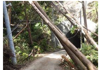
⑧ 電柱・倒木倒壊の状況 (千葉県鴨川市)
