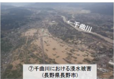
【令和元年東日本台風】
