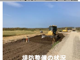
堤防整備の状況
