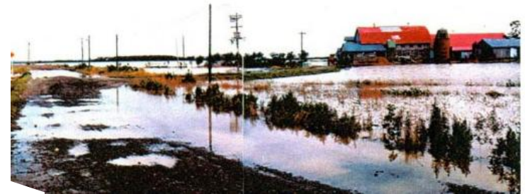
天塩川右岸の被害状況
