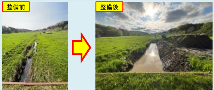
農業用排水路整備(男能富川)
